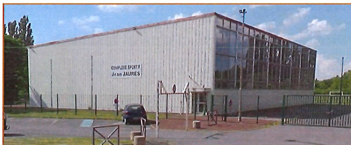
Réhabilitation de la Salle de sports Jean Jaurès
